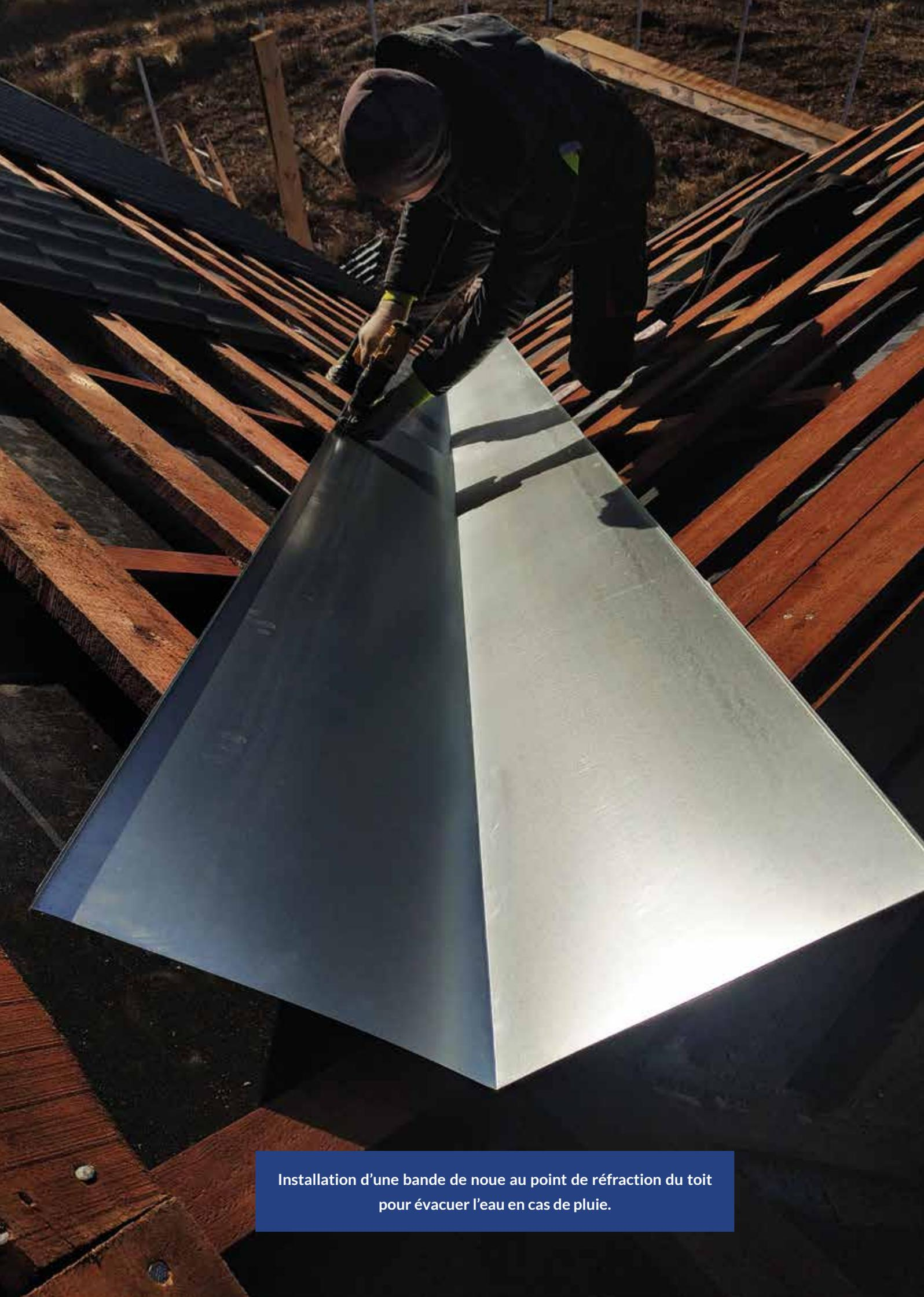
Installation d'une bande de noue au point de réfraction du toit pour évacuer l'eau en cas de pluie.
